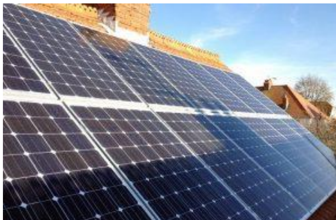
Figura 6: Sombreamento em um sistema fotovoltaico provocado por construção próxima. Fonte: Minha Casa solar, 2019.
